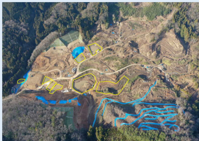
①仮設沈砂池(黄色囲み)の設置(2020年3月撮影) ※2020年3月現在で2019年10月時点の約8倍(約17,700 m 3 )の容量を確保
