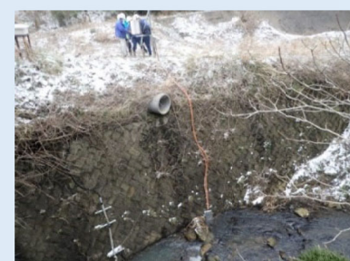
④濁水の常時監視(深谷川下流)
