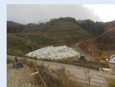
⑧濁水の発生防止(養生シートの敷設等)
