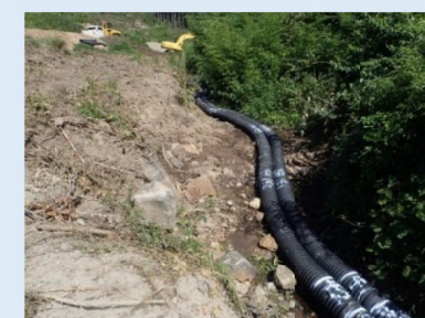
⑤仮設排水路の設置
