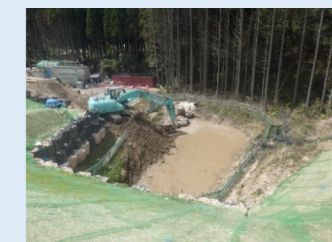
④仮設沈砂池の適切な維持管理
