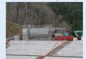
⑩濁水処理装置の設置(処理能力100t/時間②)
