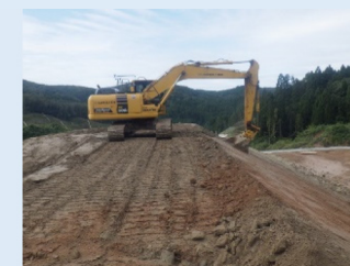
⑦降雨に備えた作業の管理(土羽打ち)
