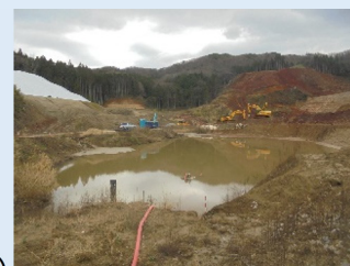
②仮設沈砂池の状況
