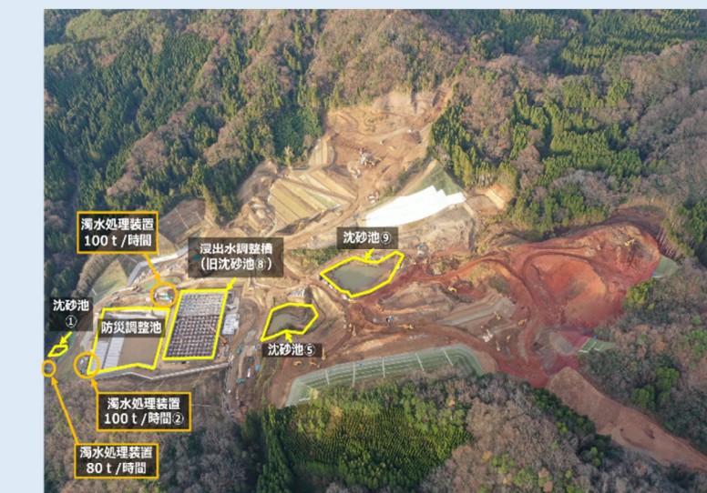
①②仮設沈砂池及び浸出水調整槽等の配置位置図(2021年12月撮影) ※防災調整池の整備や仮設沈砂池の形状を変えながら2021年12月時点で約63,200m 3 を確保
