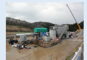
⑩濁水処理装置の設置(処理能力100t/時間①)
