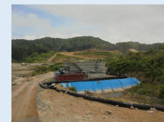
⑨濁水の発生防止(養生シートの敷設等)
