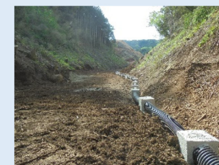
⑥仮設排水路の設置
