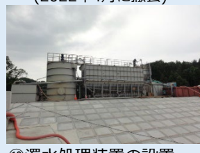
⑩濁水処理装置の設置(処理能力100t/時間②)
