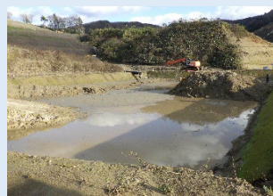
②仮設沈砂池の状況
