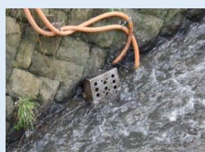
⑤濁水の常時監視(深谷川下流)
