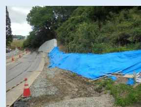
⑨濁水の発生防止(養生シートの敷設等)
