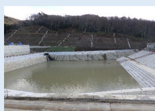
①防災調整池の状況
