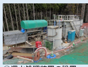
⑩濁水処理装置の設置(処理能力80t/時間)(2022年4月に撤去)
