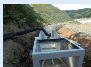
⑥仮設排水路の設置
