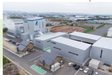
㈱花巻バイオマスエナジー 2017年2月～稼働開始
