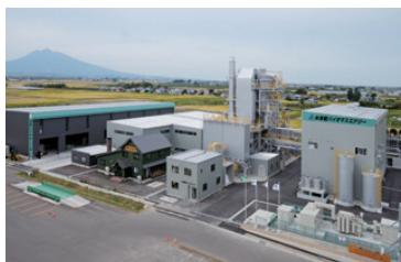
㈱津軽バイオマスエナジー 2015年12月～稼働開始
