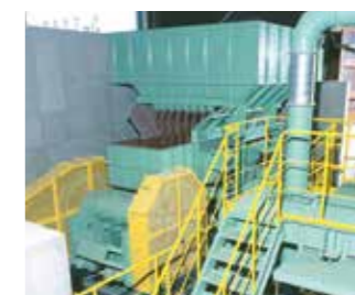
コンクリート処理施設
