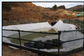
仮設沈砂池（計5箇所設置）
