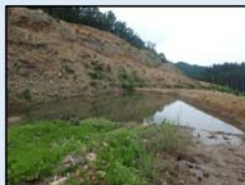
仮設沈砂池（計5箇所設置）
