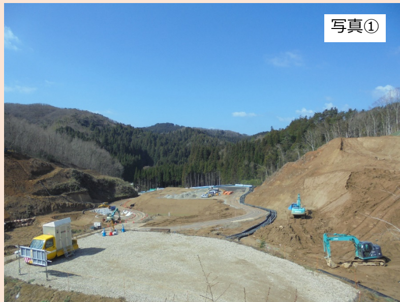
現場内に設けた見学場所（①地点）から西方向（出入口方向）を撮影したものです。 先月に引き続き、防災調整池付近の造成工事を行っており、加えて濁水対策を強化するための工事を行っています。
