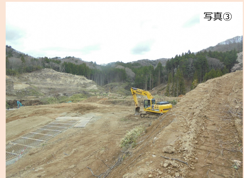
埋立地南側の斜面（③地点）から北東方向（第1期埋立地予定地）を撮影したものです。 防災調整池付近の造成工事に伴い、発生した土砂の仮置きを行っています。
