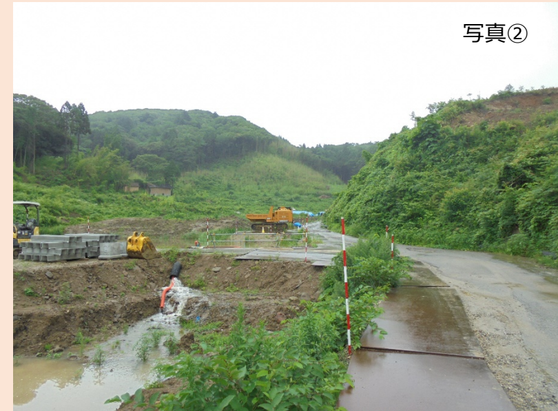
旧輪島市道（②地点）から北東方向（覆土仮置場予定地）を撮影したものです。
