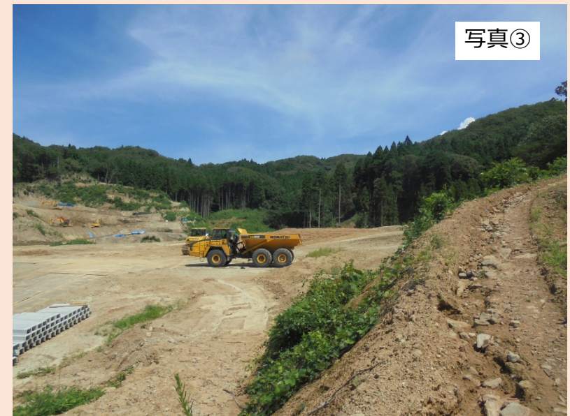
埋立地南側の斜面（③地点）から北東方向（第1期埋立地予定地）を撮影したものです。 伐採工事に加え、盛土の補強工事を進めています。
