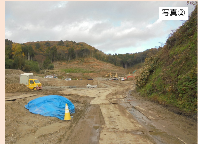
旧輪島市道（②地点）から北東方向（覆土仮置場予定地）を撮影したものです。 残土仮置場の造成工事を行っております。
