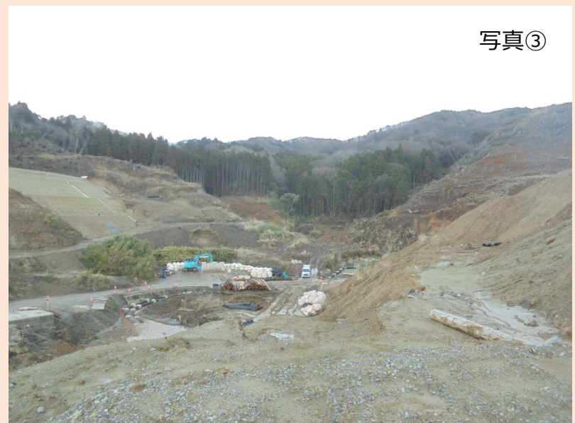
埋立地南側の斜面（③地点）から北東方向（第1期埋立地予定地）を撮影したものです。 仮置きした土砂の運搬や伐採工事を行っています。
