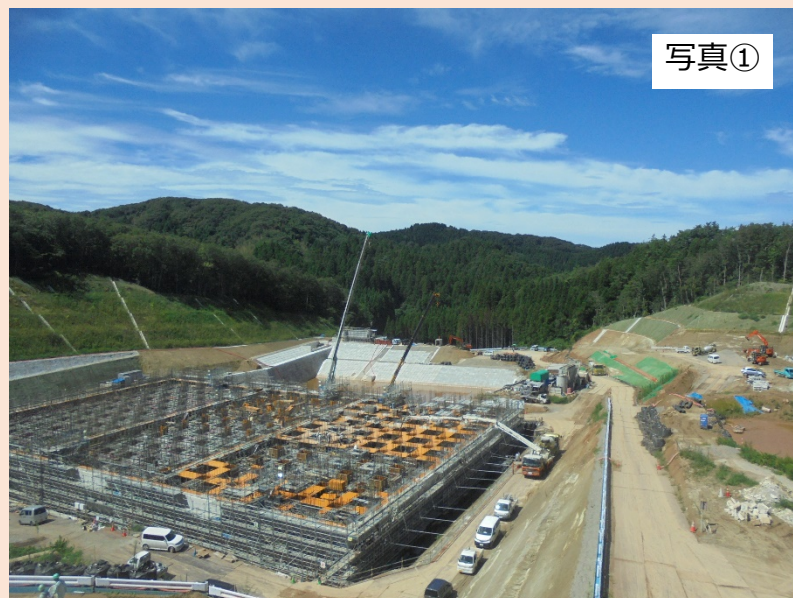
改変区域の中央（①地点）から西方向（出入口方向）を撮影したものです。 先月に引き続き、防災調整池付近の造成工事を行っております。
