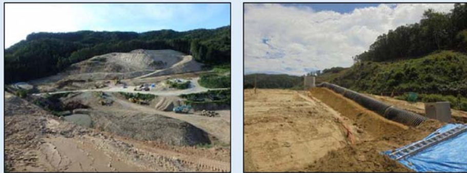
造成工事の様子
