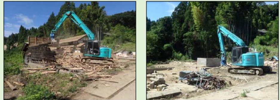
解体工事の様子
