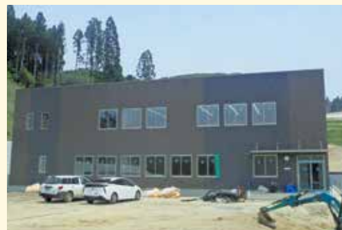
▲管理棟の外観(正面)
