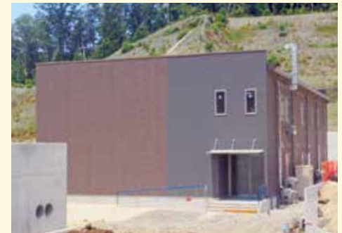
▲管理棟の外観(玄関側)
