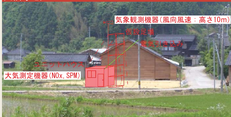
大気観測機器設置例(風向風速、ユニットハウス)
