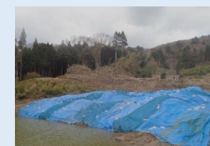
⑧濁水の発生防止(養生シートの敷設等)
