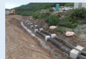
⑤仮設排水路の設置
