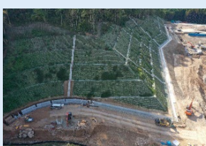
②造成した法面等の速やかな緑化
