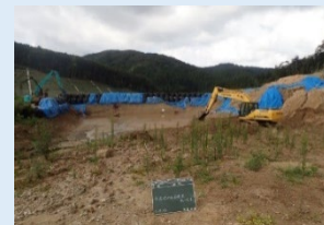
③仮設沈砂池の適切な維持管理
