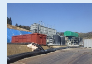
⑨濁水処理装置の設置(処理能力100t/時間)
