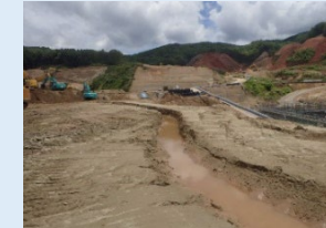
⑥降雨に備えた作業の管理(土側溝による雨水の切り回し)
