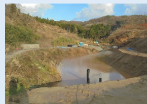
①仮設沈砂池の状況
