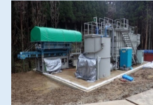
⑨濁水処理装置の設置(処理能力80t/時間)
