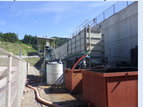
⑩濁水処理装置の設置（処理能力60t/時間） （2023年10月に撤去）
