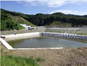
②仮設沈砂池の状況
