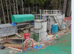
⑩濁水処理装置の設置（処理能力80t/時間） （2022年4月に撤去）
