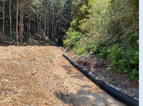
⑥仮設排水路の設置
