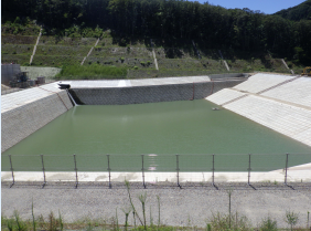
①防災調整池の状況
