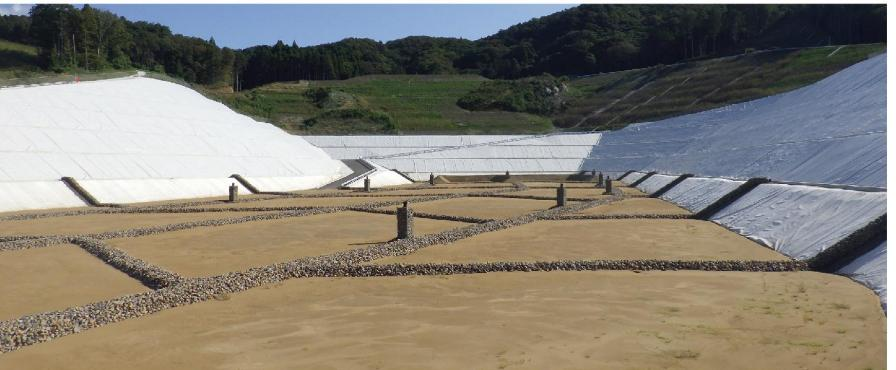
浸出水（廃棄物に接した雨水）を外部に流出させないようにするために、埋立地の底面および側面には遮水工を設置しています。遮水工の構造は、強固な基礎地盤の上に二重の遮水シートによる表面遮水工を採用しており、シートの材質には高密度のポリエチレンシートを使用しています。
