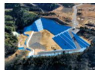
安定型品目を埋立処分する(株)タケエイの成田最終処分場
