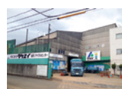
28 塩浜リサイクルセンター 積替保管施設 [神奈川県川崎市]
