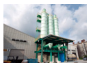
19 (株)グリーンアローズ関東 廃石膏ボードのリサイクル工場 [神奈川県横須賀市]
