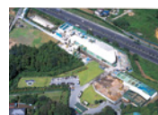
25 四街道リサイクルセンター 混合廃棄物のリサイクル工場 [千葉県四街道市]
