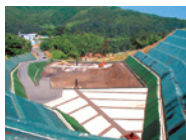
管理型品目を埋立処分する(株)北陸環境サービスの最終処分場
