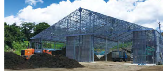
(株)タケエイグリーンリサイクルの堆肥化施設
