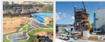
タケエイソーラーパーク成田 (株)津軽バイオマスエナジー
