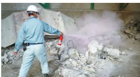
消火器の噴射訓練
